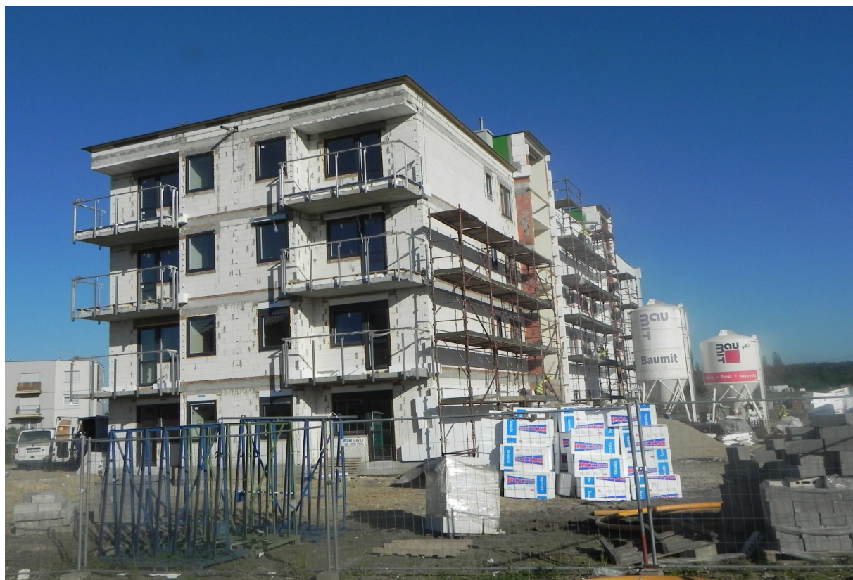
Budynek ul. Winna 33
